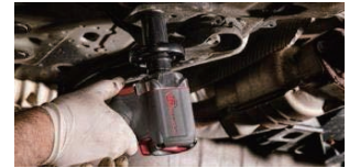
サブフレームボルト
